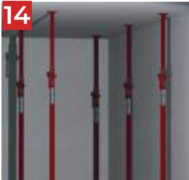
Démontez les étais et les contreplaqués et mettez en place les étais de séchage pour soutenir la structure en cours de durcissement.
