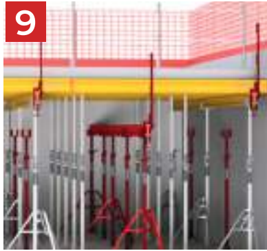
9 Libérer l'espace sous le coffrage en enlevant l'ensemble des étais renforts et les files intermédiaires.
