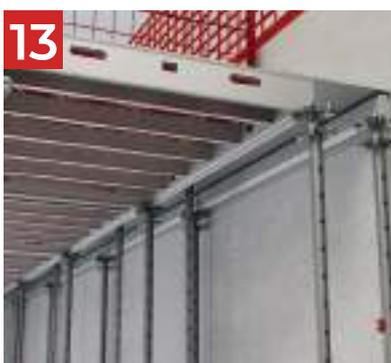
Mettre en place des étais sous les tôles métalliques pour éviter tout risque de chute durant le décoffrage.
