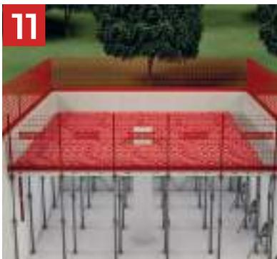
Mettre en place les éléments de sécurité avant tout accès au-dessus du coffrage.
