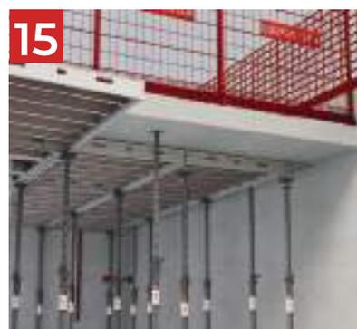
Assurer l'installation des étais de séchage au fur et à mesure du décoffrage des panneaux.
